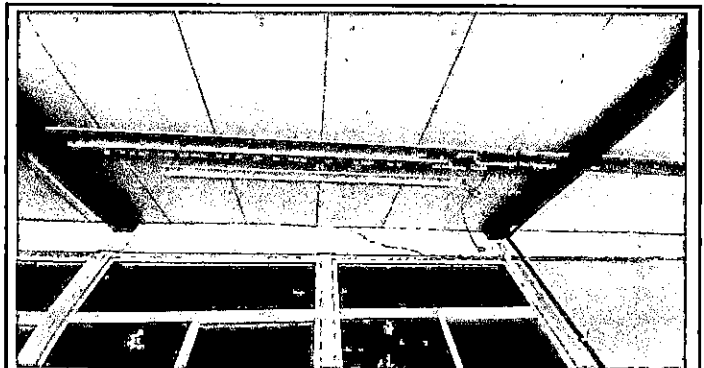
sustitucion de plafoneras
